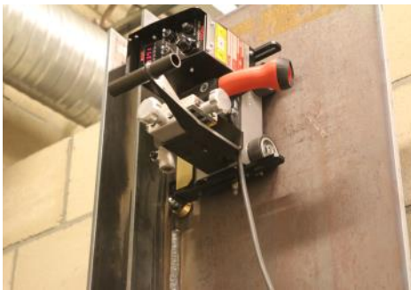
Soldadura en ángulo vertical
