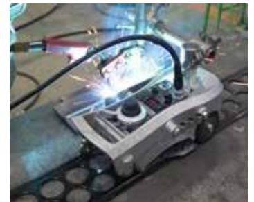
Soldadura con oscilación
