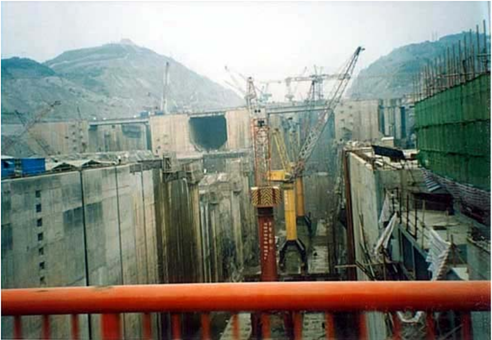
中国ダム建設現場
